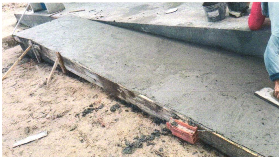
FOTO 02 – Rampa padrão para acesso de deficientes a passeio público, em concreto simples Fck=25MPa, desempolada, pintada em novacor, 02 demãos e piso tátil de alerta/direcional.
