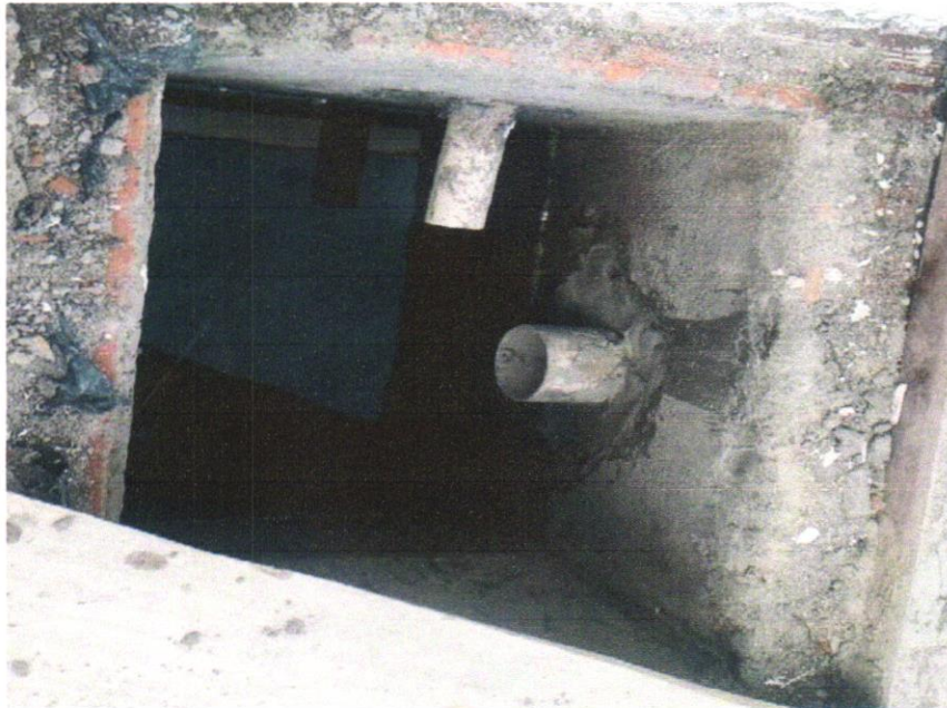
Foto 15 - Caixa de inspeção 0,30 x 0,30 x 0,40m
