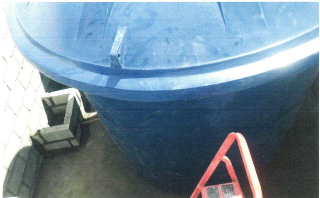
Foto 04 - RESERVATÓRIO DE POLIETILENO 10.000 LITROS
