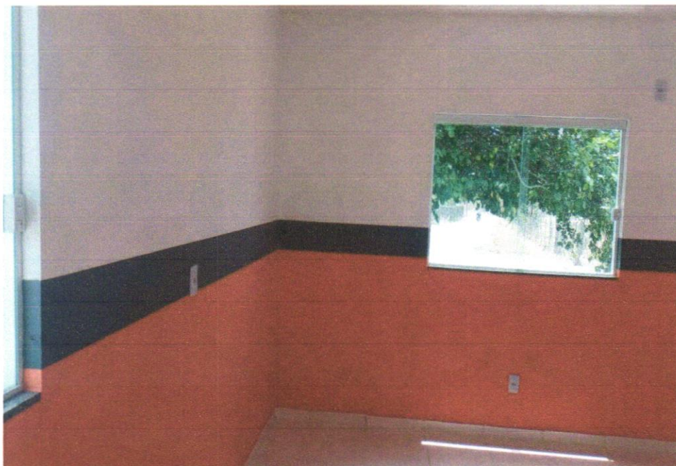
Foto 12 - APLICAÇÃO MANUAL DE PINTURA COM TINTA LÁTEX ACRÍLICA EM PAREDES, DUAS DEMÃOS. AF_06/2014
