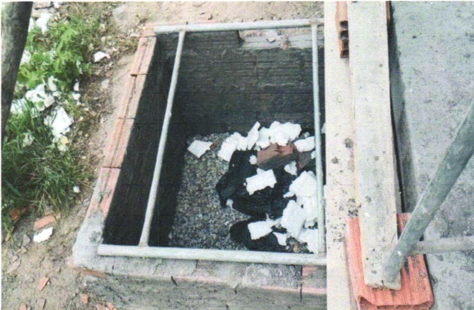
Foto 14 - Fossa séptica pré-moldada, tipo oms, capacidade 20 pessoas (v=1410 litros)
