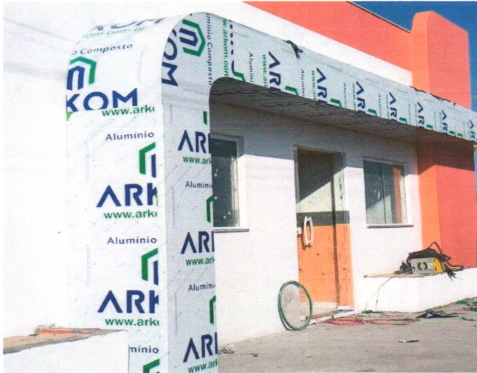
Foto 07 - Revestimento metálico em alumínio composto (Alucobond), e=0,3\text{mm} , pintura Kaynar 500 composta por seis camadas, inclusive estrutura metálica auxiliar em perfil de viga "U" de 2" - fornecimento e montagem
