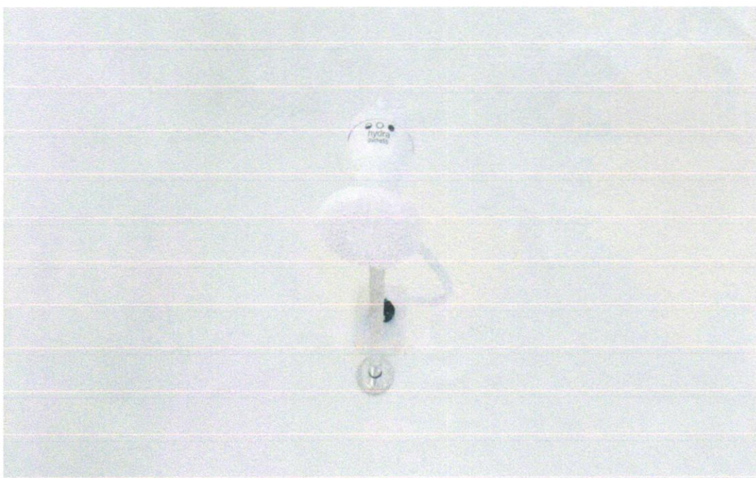
Foto 06 - CHUVEIRO ELÉTRICO COMUM CORPO PLÁSTICO, TIPO DUCHA ☑ FORNECIMENTO E INSTALAÇÃO. AF_01/2020
