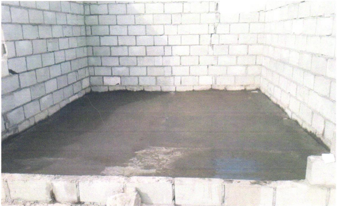
FOTO 03 – Concreto simples fabricado na obra, fck=25 mpa, lançado e adensado
