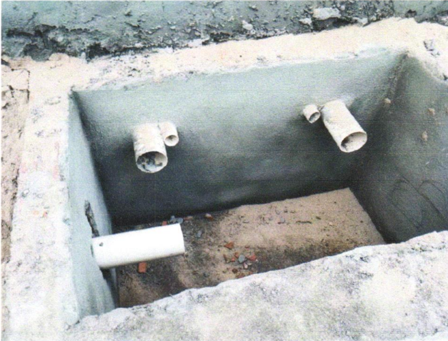
Foto 13 - Sumidouro paredes com blocos cerâmicos 6 furos e dimensões internas de 1,75 x 1,00 x 1,00 m
