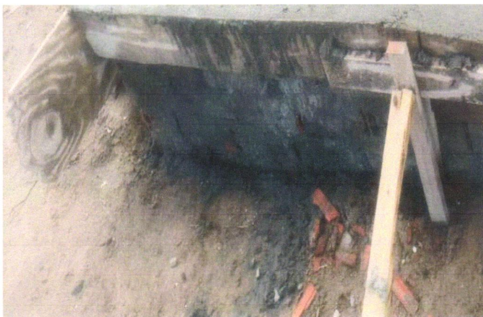
FOTO 01 – CHAPISCO APLICADO EM ALVENARIAS E ESTRUTURAS DE CONCRETO INTERNAS, COM COLHER DE PEDREIRO. ARGAMASSA TRAÇO 1:3 COM PREPARO EM BETONEIRA 400L. AF_06/2014
